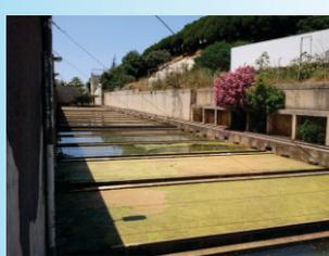
Filterre de sable rapide à Dbayeh: besoin de lavage fréquent pour prévenir les bouchons.
