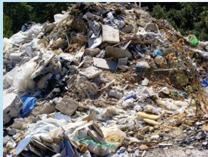
Déchets de construction mélangés avec du plastique.
