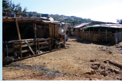
Elimination des effluents dans une ferme.
