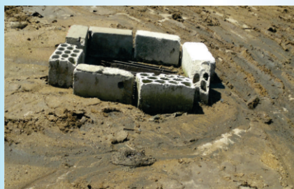
Evacuation des déchets liquides: effluents déchargés, dans une fosse à fond perdu, sans traitement, en absence d'un système de drainage adéquat.
