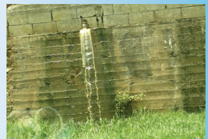
Décharge des effluents non traités d'un abattoir dans l'environnement.
