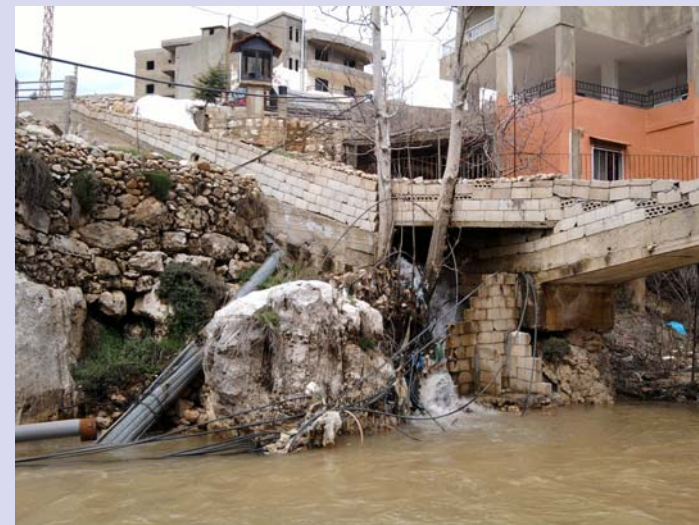
مصّب مياه الصرف الصحي الغير معالجة في نهر الصليب في حراجل
