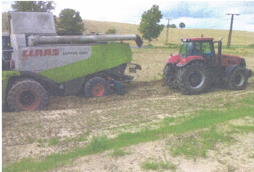
Versackte Maschinen und tiefe Fahrspuren im ehemaligen Rohrgrabenbereich.
